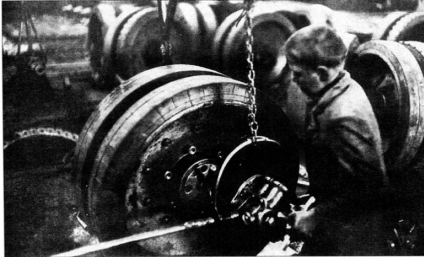
Сборка катков в пары на заводе № 112 во время войны. Видно, что на обрезиненных катках отсутствует перфорация. Танки Т-34-85 с подобными катками появились во второй половине 1944 года.
